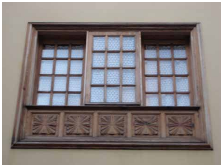
Mehrschichtige Fensterkonstruktion mit innenliegender Verschattung, Teneriffa, 2011
