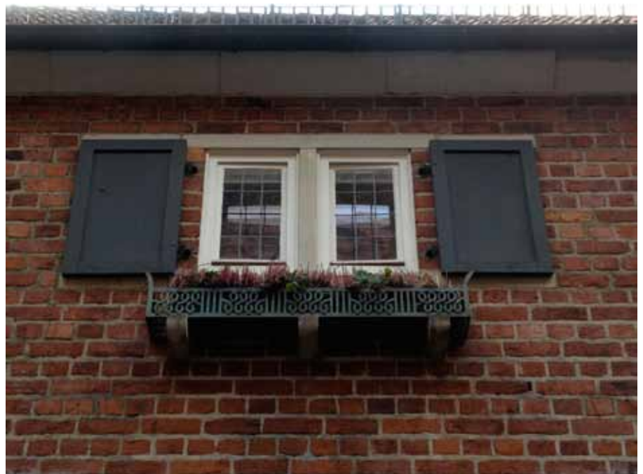
Kleine Belichtungsöffnungen mit Wetterschutz-Läden, Bremen, 2012
