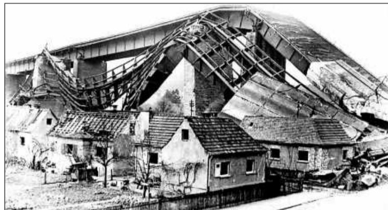
1945 von der Wehrmacht gesprengt: Die Pfeiler halten stand. FOTO: STADTARCHIV KL
