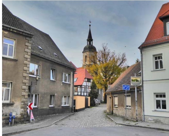
Gefährdete Bausubstanz am alten Kirchhof in Ortrand/Lausitz
